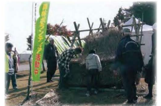
親子で茅葺き屋根の表面を整える作業を体験
